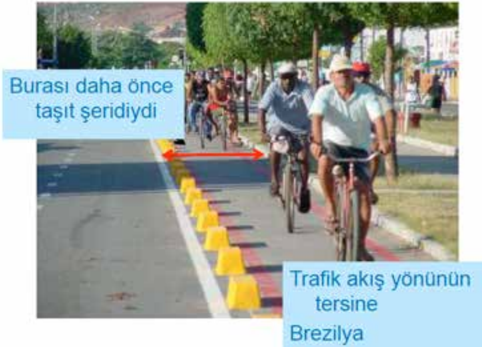
Şekil 3: Fiziki ayrıma sahip bisiklet yolu tasarımı (Brezilya)
